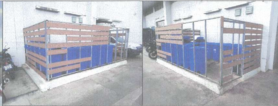
ภาพแสดงตำแหน่งซอมแซมผนังห้องพักขยะ
